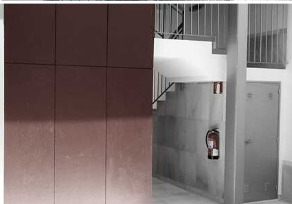
Rehabilitación edificio de viviendas | Cádiz
