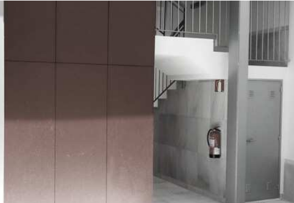
Rehabilitación edificio de viviendas | Cádiz
