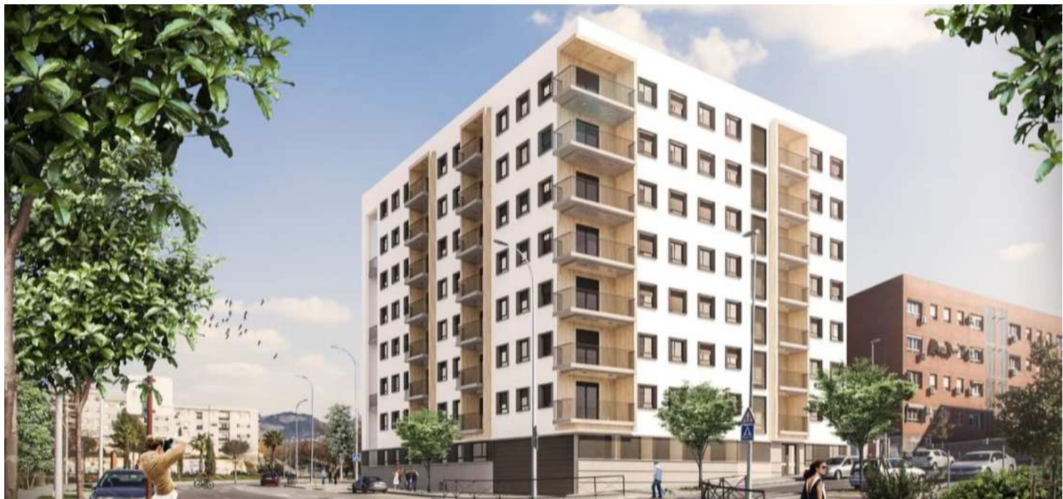
Proyecto en ejecución | Nueva construcción 31 VPO, garajes y trasteros PP-N3 | Granada
