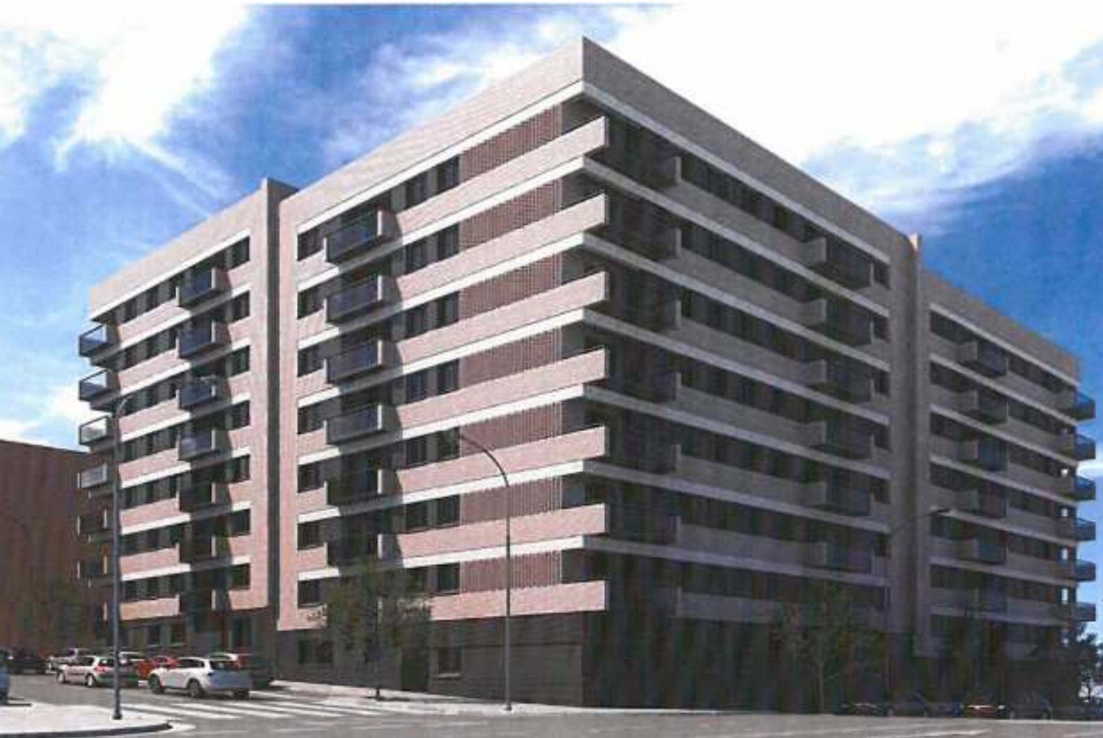
Proyecto en ejecución | Nueva construcción 85 VPO, aparcamientos y trasteros MC-2 del PP-N3 | Granada
